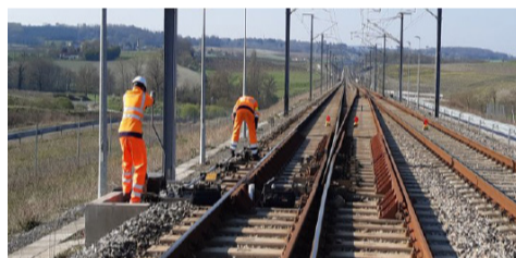
Opérations de maintenance sur la ligne à grande vitesse Sud Europe Atlantique.
