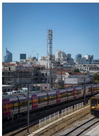
Pylône de radiocommunication déployé par SYNERAIL.
