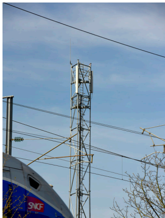
Pyône de radiocommunication déployé par SYNERAIL.
